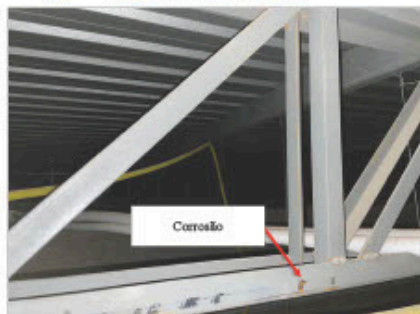
Figura 5 – Corrosão
