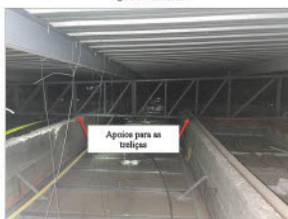
Figura 6 – Apoios para as treliças
