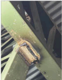
Figura 22 – Ligação da treliça com região que retiraram os pilares
